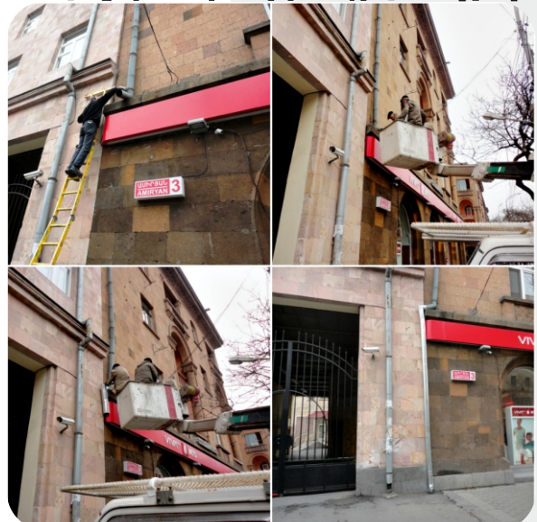
197 շենքերում իրականացվել են 3836 գծմ ջրթափ խողովակների նորոգման աշխատանքներ: Ջերմամեկուսացվել է 1180 գծմ խողովակ: Մաքրվել և նորոգվել են 2 շենքերի ճակատային հատվածներ: 4 շենքերում իրականացվել են թափվող սալիկների տեղադրման աշխատանքներ:
