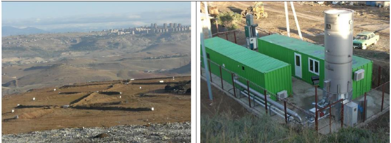
Նկար 5.1. Մեթանի կորզման հորերի տեղաբաշխումը Նուբարաշենի ԿԿԹ աղբույսի «Բլոկ Բ-արևմտյան» հարթակում (ձախից), մեթանի այրման կայանքը (ՄԹԱԿ, աջից)
