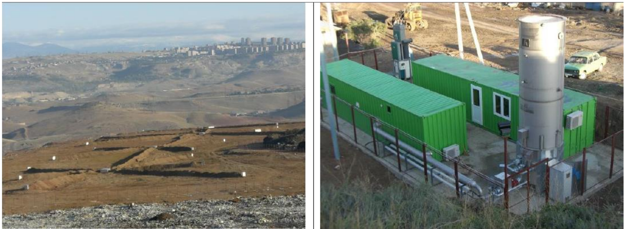
Նկար 24 Մեթանի կորզման հորերի տեղաբաշխումը Նուբարաշենի ԿԿԹ աղբույսի «Բլոկ Բ-արևմտյան» հարթակում (ձախից), մեթանի այրման կայանքը (ՄթԱԿ, աջից)
