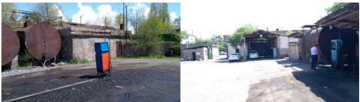
a) Nor Nork (Jrvej) depot
